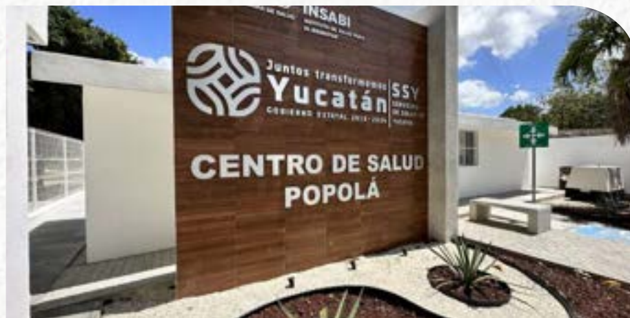
Rehabilitación u chúumukil le Popolá
