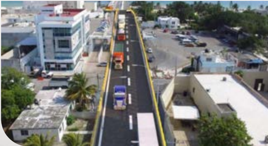
Viaducto elevado u Progreso
