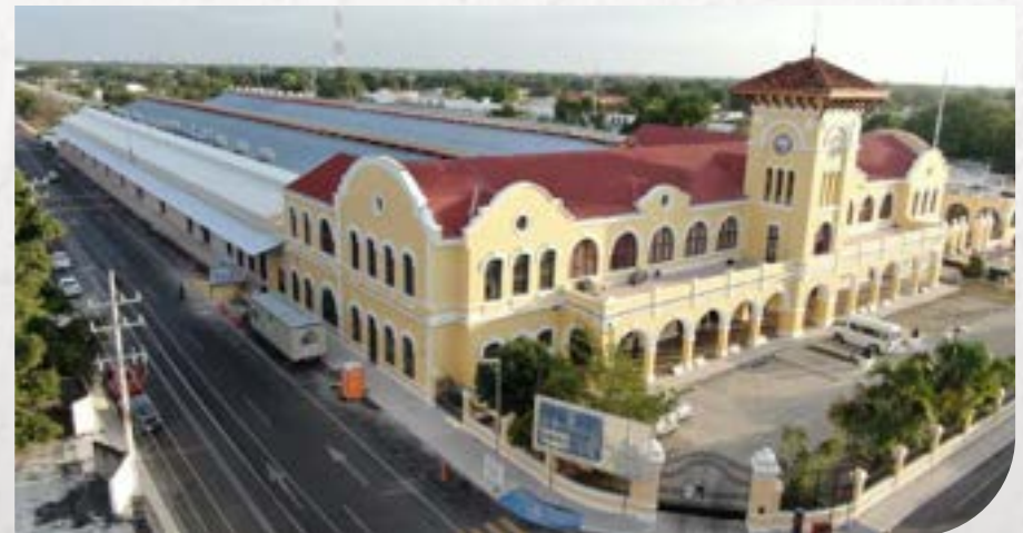
Fachada le UNAY
