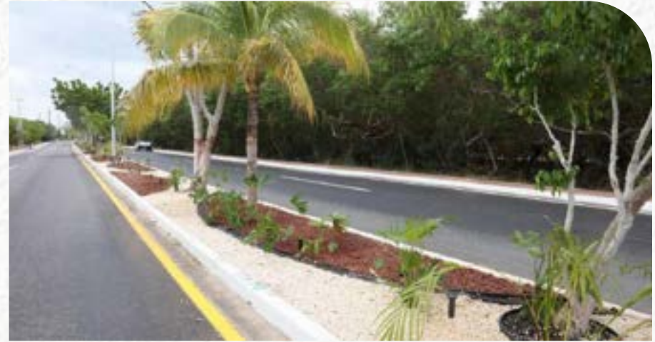
Rehabilitación carretera Progreso-Chicxulub
