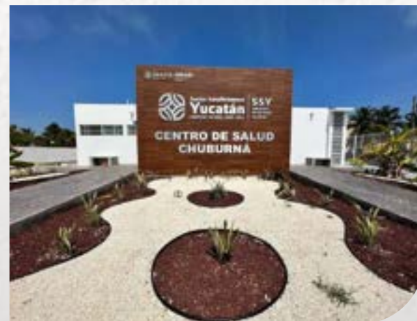
Rehabilitación u chúumukil le Chuburná
